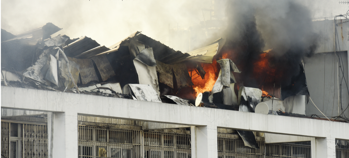
楼顶板房被完全烧毁
