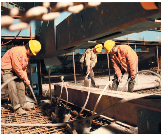
合龙现场工人正在施工
