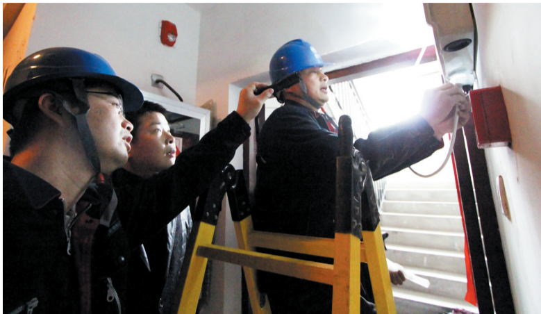
工作人员在孔庆斌家安装光伏电网
