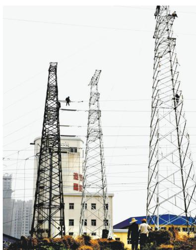
为配合合作化路高架桥建设,合肥供电将合作化路与休宁路接口的高压走廊17座铁塔进行增高,升高后最高的铁塔达到39米,整个改造工程7月前完工。
